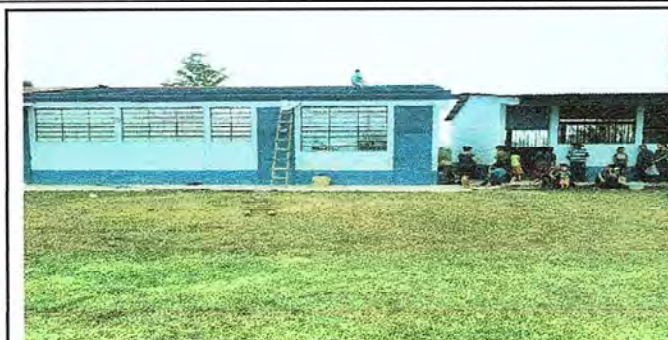
Foto 1: Cambio de lamina por lamina troquelada
