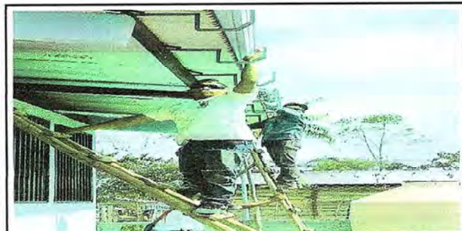
Foto 3: Instalacion de canal
