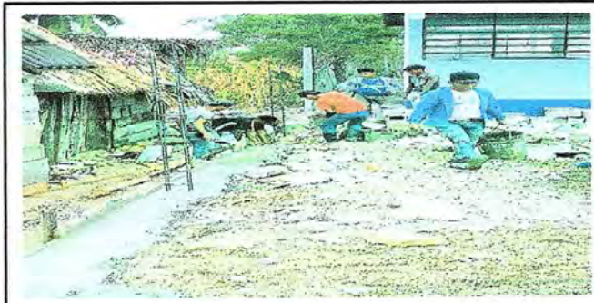
Foto 4: Reparacion de muro perimetral
