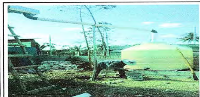
Foto 5: Instalacion de tinaco.
