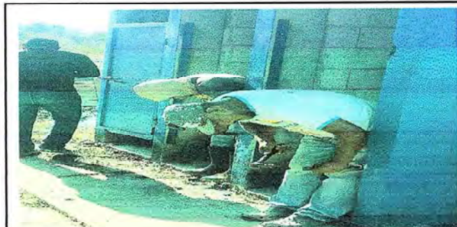
Foto 6: Reparacion de puertas de baño
